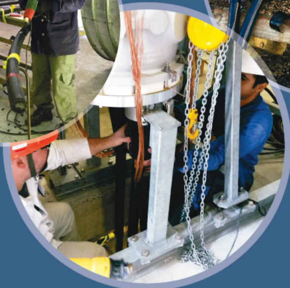
montagem da terminação GIS
