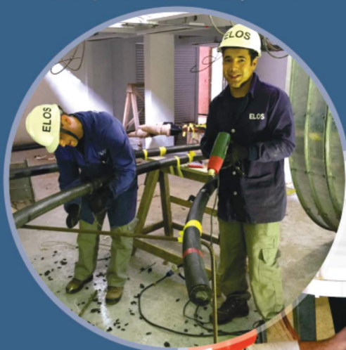
Montagem de terminação 69kV
