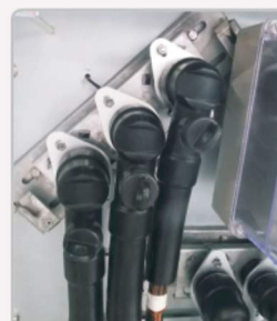
Fig. 1 – Detalhe de montagem de um ECDP 250-3 com terminações TDEC 250.
