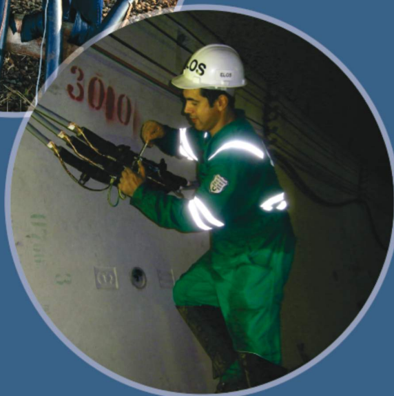
montagem de emenda com desconectável
