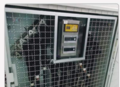
Fig. 2 – Detalhe de montagem de um ECDP 250-4 com terminações TDEC 250 e indicação de tensão.
