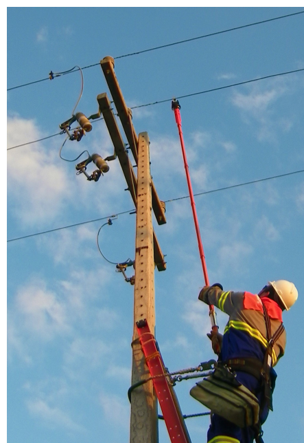
FIG. 4 – Montagem em linha viva
