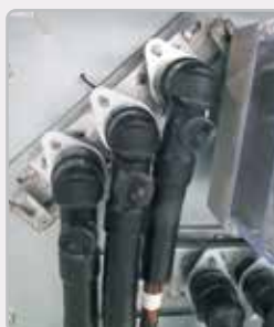
Fig. 1 – Detalhe de montagem de um ECDP 250-3 com terminações TDEC 250.
