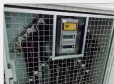
Fig. 2 – Detalhe de montagem de um ECDP 250-4 com terminações TDEC 250 e indicação capacitiva VOIS.
